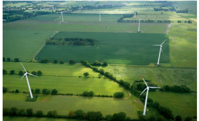
Beim Repowering des Windparks Horst in Schleswig-Holstein von 10,4 auf 28 MW beeinträchtigen Netzprobleme den Umbau.
